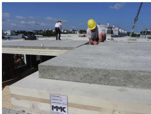
Bildlegende: Montage der XC ® Deckenelemente
