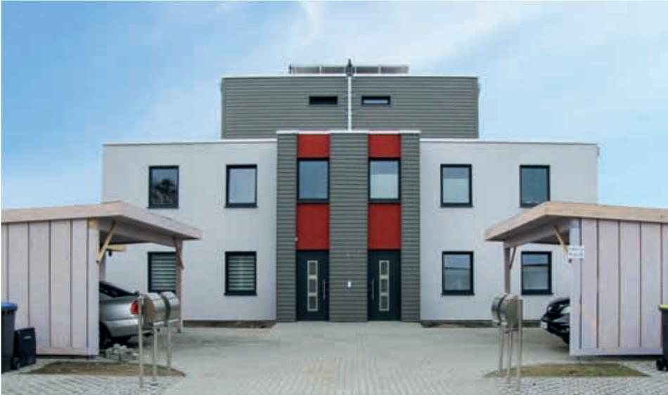
Dans le cas de ce bâtiment de trois étages présentant une surface habitable totale de 400 m<sup>2</sup> partagée entre quatre familles, les murs extérieurs et intérieurs, les planchers et la toiture ont été réalisés avec des éléments constructifs **MM HBE**.
