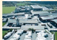
Mayr-Melnhof Holz Gaishorn am See Usine de seconde transformation
