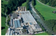
Mayr-Melnhof Holz Reuthe Ahşap işleme fabrikası, Pelet
