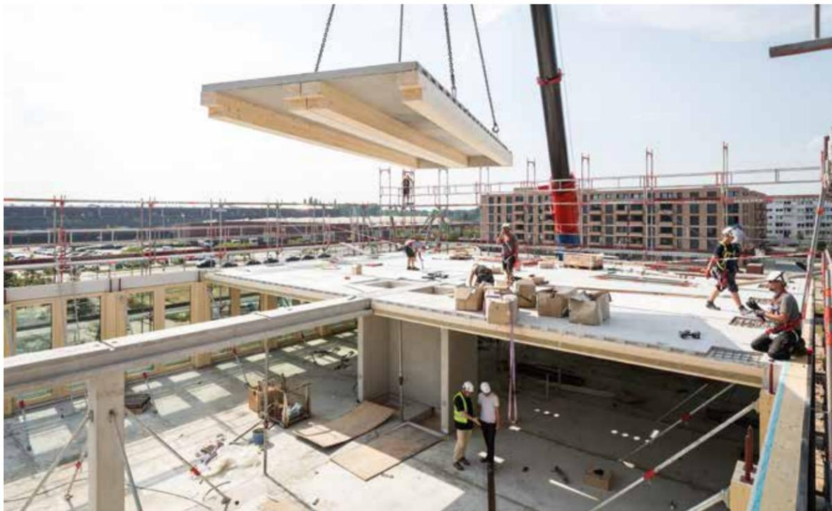
Das CREE System und die CREE Holz-Hybriddecke. Derzeit über 220.000 m<sup>2</sup> gebaute (bzw. im Bau befindliche) Systemflächen.
