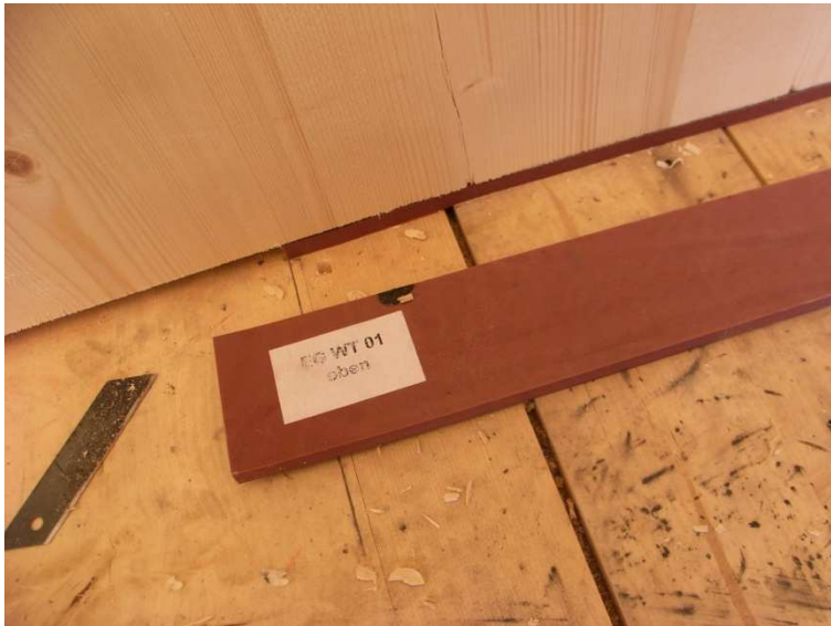
Abbildung 64: Sylomerelager im Auflagerbereich zur Entkoppelung
