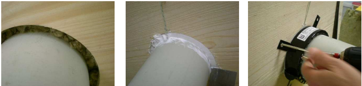
Abbildung 87: Einbau einer Brandrohrmanschette direkt in einer unbedeckten Massivholzwand; links: ausstopfen des Ringspaltes, Mitte: intumeszierende Brandschutzmasse, rechts: Befestigung der Brandrohrmanschette
