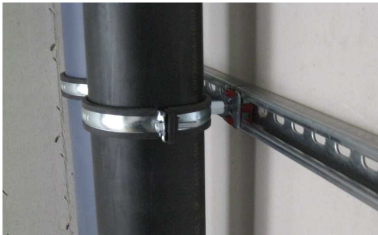
Abbildung 81: Schallschutztechnische Entkoppelung der Rohre
