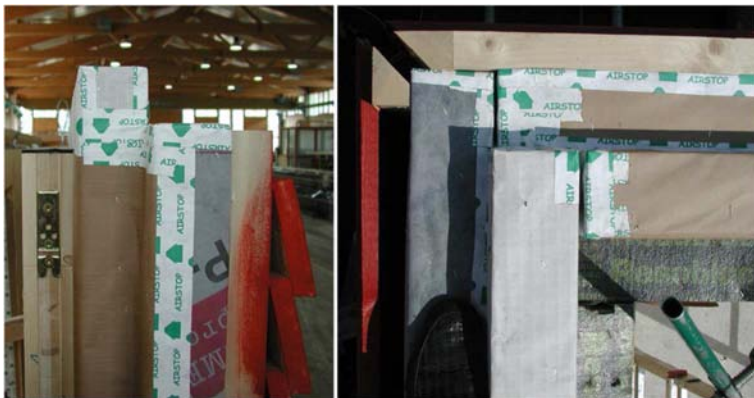
Abbildung 55: Außenwanddecke: links Vorfertigung (Ansicht); rechts Montage (Draufsicht)
