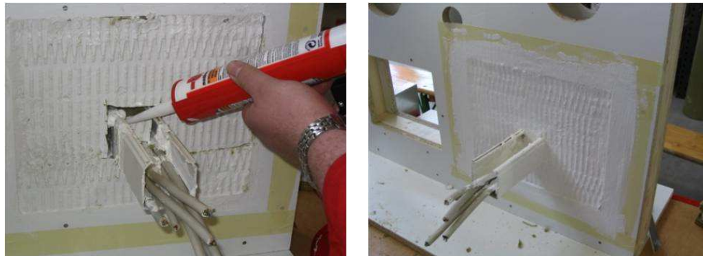
Abbildung 86: Abdichtung der Kabeldurchföhrung und fertige Abschottung, Quelle: Firma Würth
