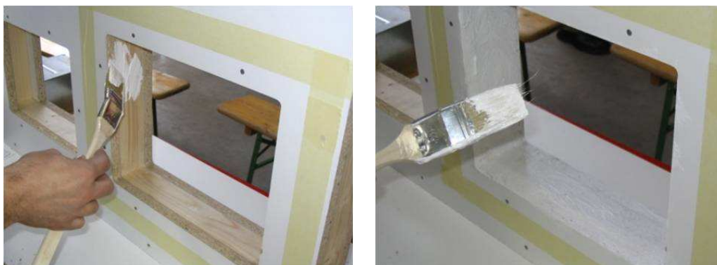
Abbildung 84: Anbringen der Beschichtung an der Leibung und an der Leibungsverkleidung, Quelle: Firma Würth
