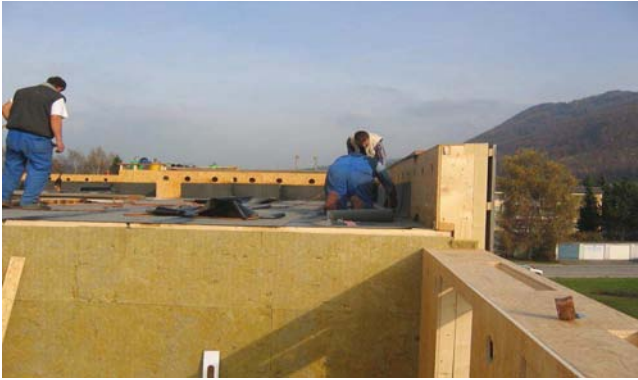
Abbildung 46: Dampfbremse (Bitumenabdichtung) am Flachdach als Bedarfswitterungsschutz
