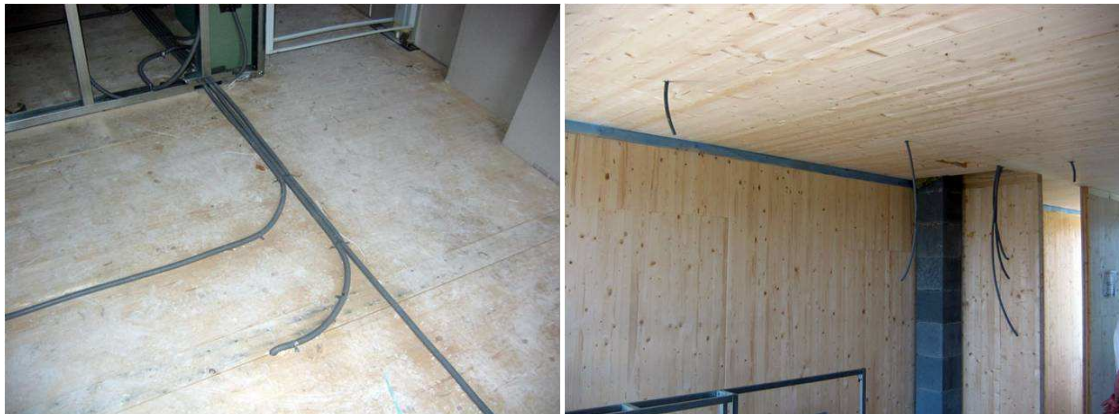
Abbildung 37: E-Leitungsführung bei sichtbarer Brettsperrholzdecke ist luftdicht auszuführen
