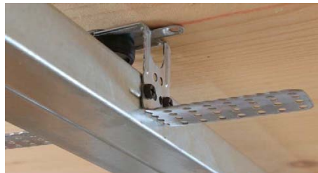
Abbildung 39: Befestigung mit entkoppelter Abhängung von Schwingbügel, Quelle: Firma Knauf
