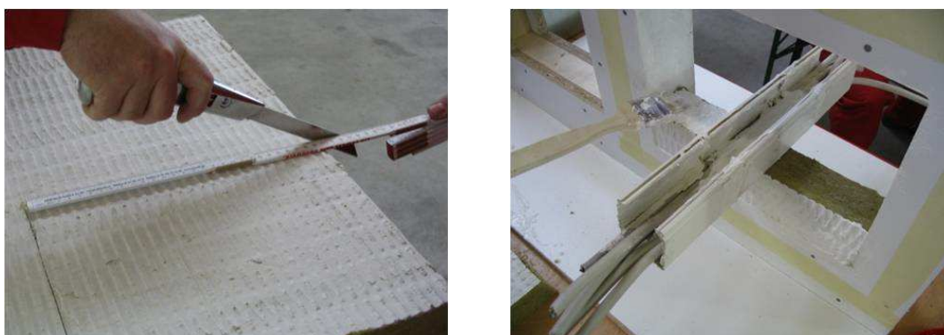
Abbildung 85: Zuschnitt der Mineralfaserplatte und Beschichtung der Platten und der Leibung, Quelle: Firma Würth
