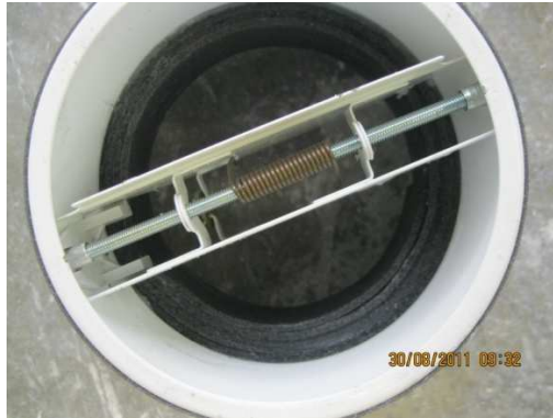
Abbildung 89: Ansicht eines Feuerschutzabschlusses auf Basis intumeszierender Materialien mit Verschlusselement (FLI-VE)
