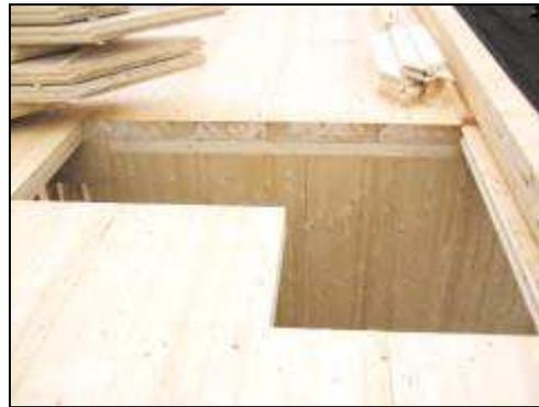
**Abbildung 4-12:** Decke - Massivholzbauweise
