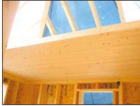
**Abbildung 4-11:** Decke - Holzrahmenbau
