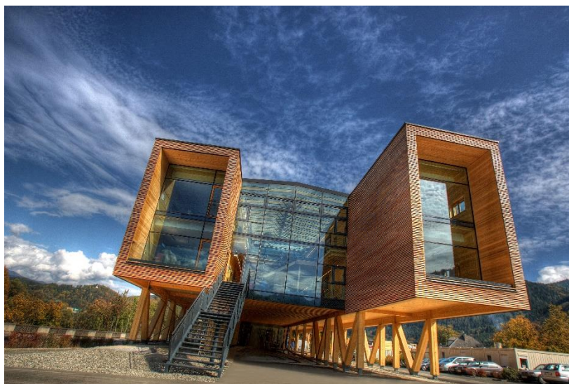
Konzernzentrale Mayr-Melnhof Holz Holding AG, Leoben, Österreich (Fotocredit: Morgenstern)
